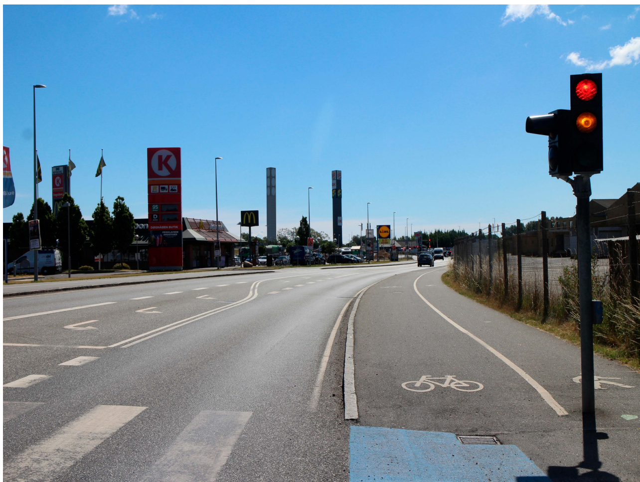
Herover ses pylonen mellem eksisterende skiltning ved Storebæltsvej - kig mod øst fra krydset Storebæltsvej/Banegårdsalleen.
